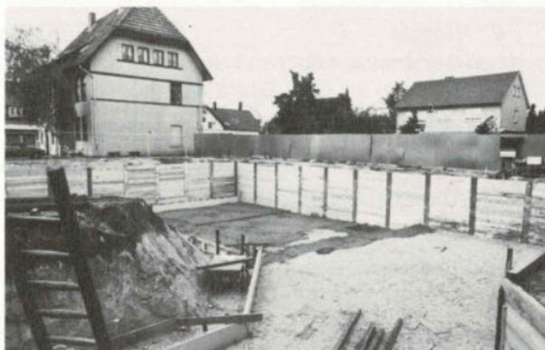
verstärkt, so daß eine ausreichende Absicherung gegenüber evtl. drückenden Erdmassen erreicht wurde. Durch eine Grundwasserabsenkung wurde der gesamte Bereich der Baugrube trockengelgt. Innerhalb von zwei Tagen konnte dann das Erdreich ausgebaggert und abgefahren werden. Der Baukran wurde aufgestellt. Er überragt die umliegenden Häuser um etliche Meter und ist weithin sichtbar.
