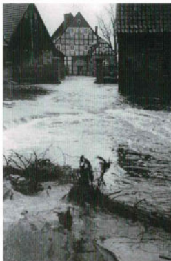
Hochwasser 1946 Das Wasser von Lutter und Reiberbach schwappte bei Mumperow über die Ufer und floss durch das Gebäude
