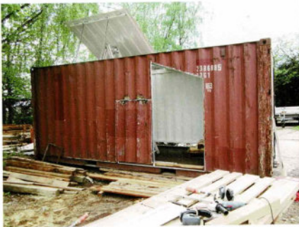
Der Container in der Ausbauphase
