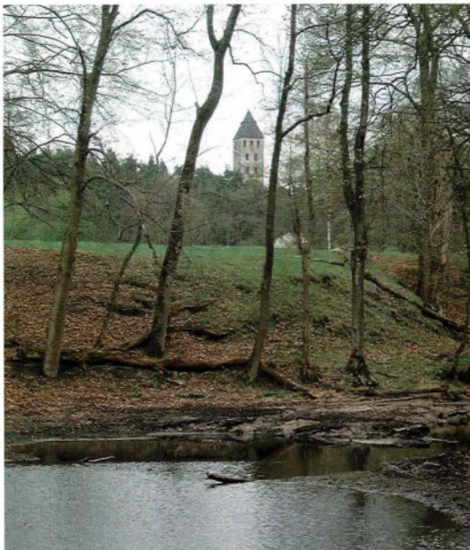
Der „Haustenbecker Turm“, 1940 erbaut, gilt seit dem Einbezug Haustenbecks in den Truppenübungsplatz als Wabyzzeichen. Er ist solide gebaut wie ein Kirchturm, ist aber lediglich ein Beobachtungsturm für das Militär.
