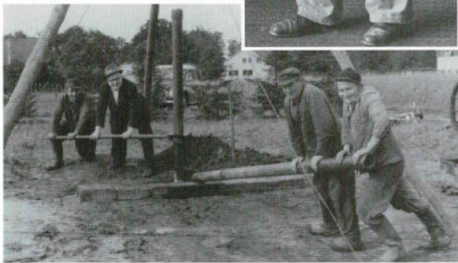
Mitarbeiter der "Kupferschmiede Giljohann" beim Bohren eines Hausbrunnens
