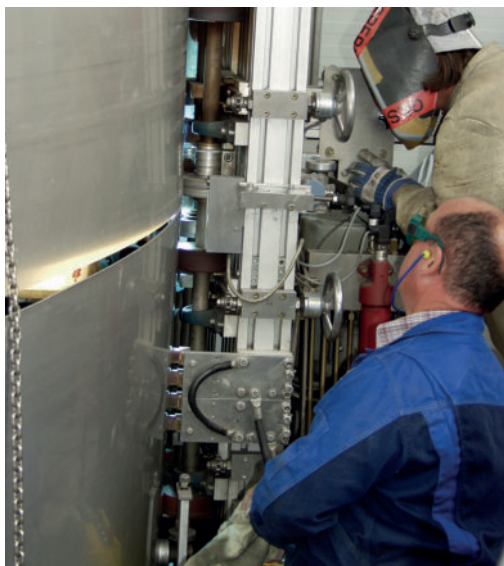
Aufwendige Schweißarbeiten an der beiden neuen Vorratsbehältern (Anbau 2007/2008)
