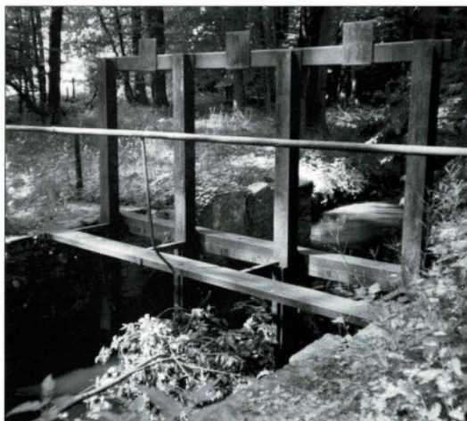
Das Stauwerk am Reiherbach.
