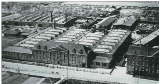
Die neu errichteten DUX-Automobilwerke, ein wesentliches Stück Lebensarbeit Gustav Schürmanns
