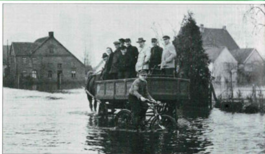
Hochwasser auf der Haller Straße
